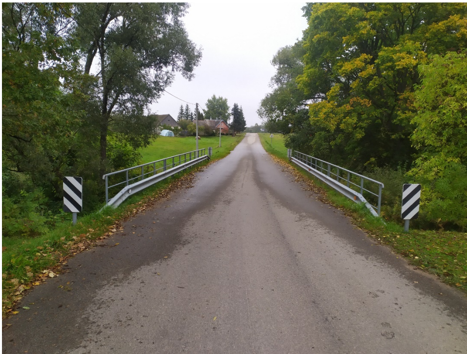
1 pav. Tilto vaizdas nuo kelio į Subačiaus pusę
