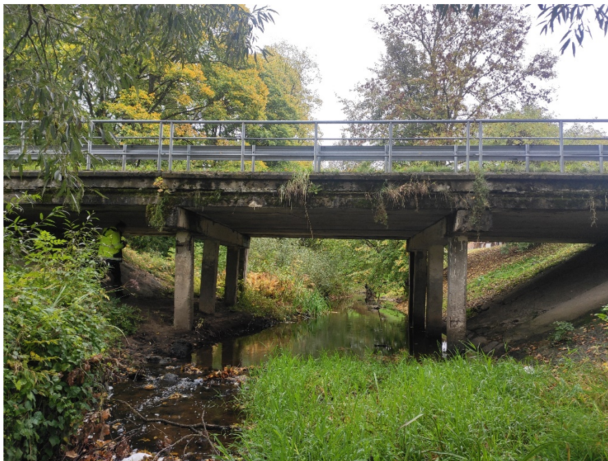
2 pav. Tilto fasadas
