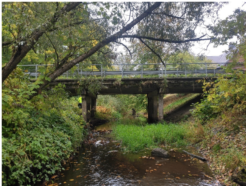
3 pav. Tilto fasadas aukštupio pusėje.
