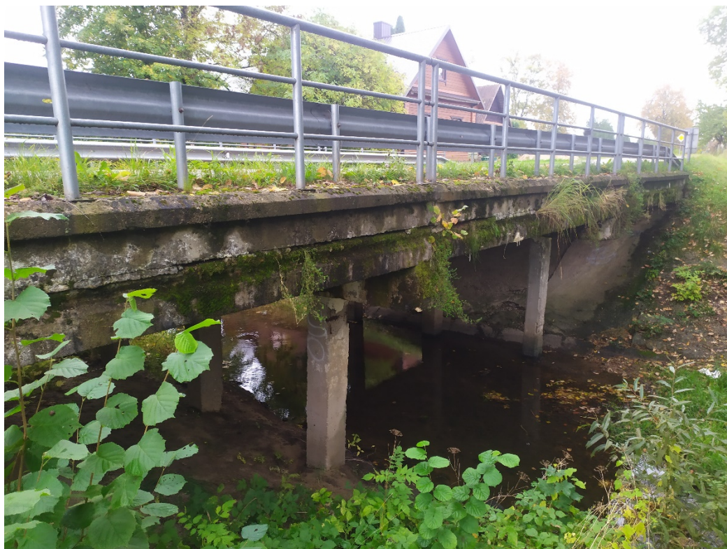
7 pav. Kraštinės plokštės apsamojusios, drėgsta
