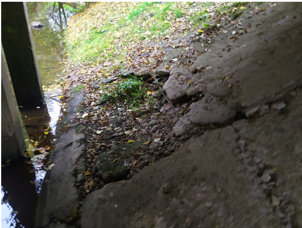
11 pav. Pažeistas kūgių tvirtiniams
