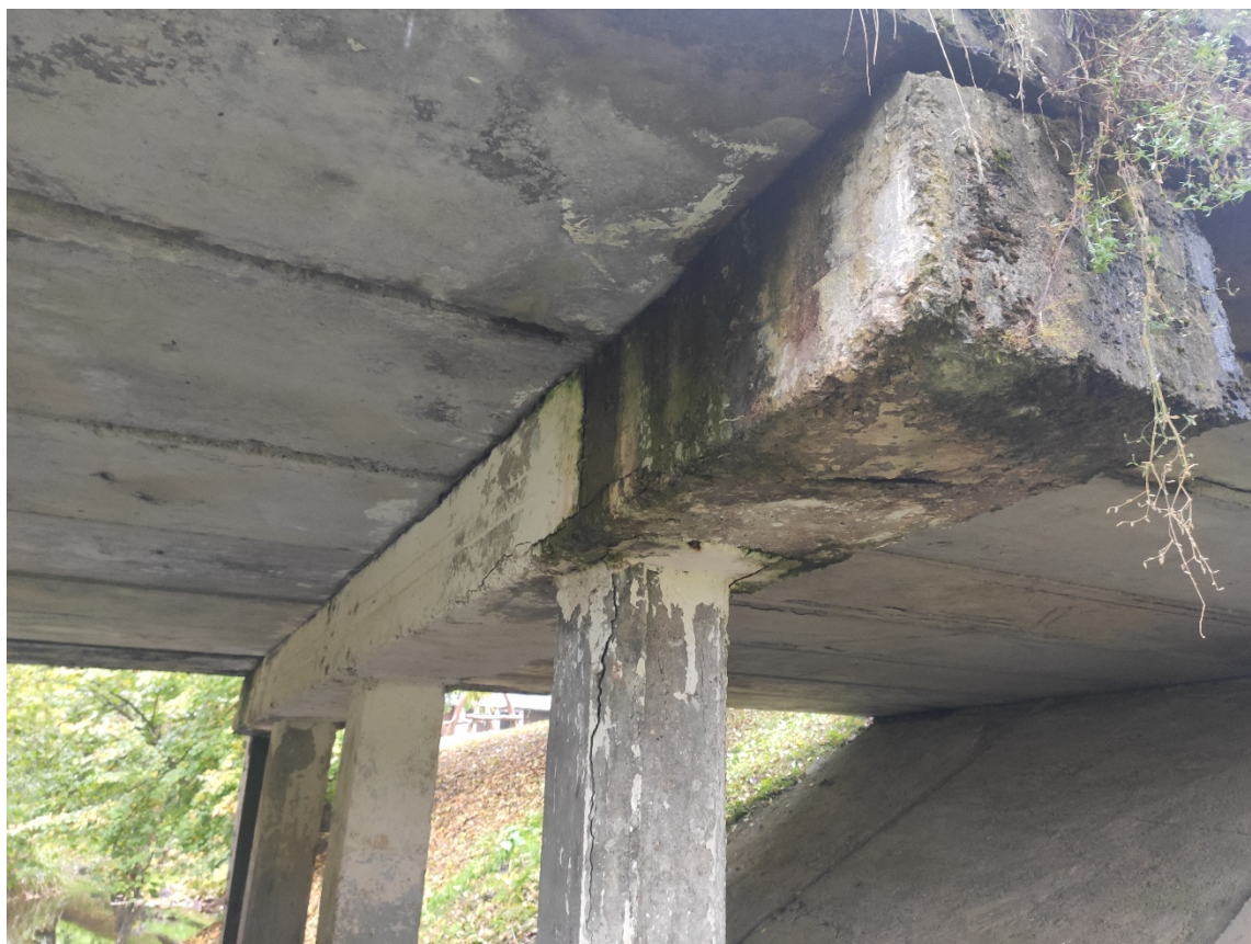
9 pav. Apsamanojė rygeliai, nuolat drėkinami
