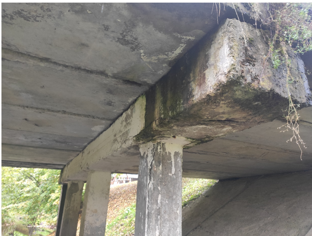
6 pav. Deformaciniai pjūviai nesandarūs
